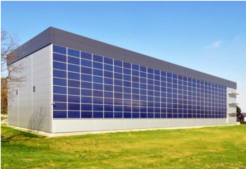
Κτίριο A+ κατά ΚΕΝΑΚ (όψη με φωτοβολταϊκά πανέλα)
